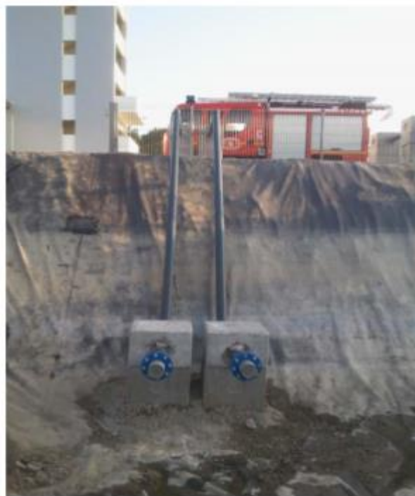
Deux colonnes de 100 mm sur une réserve d'eau ouverte
